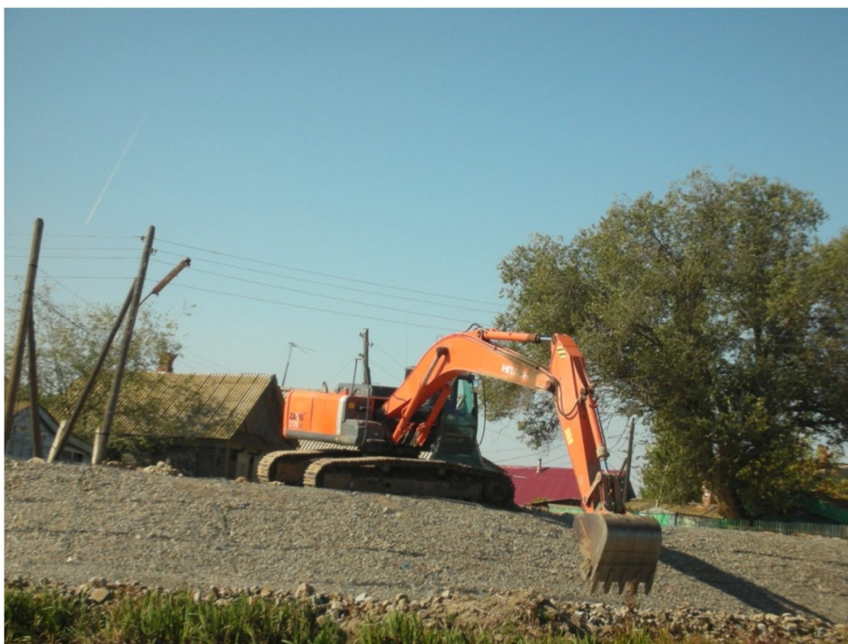
Рис. 1. Начало берегоукрепительных работ
